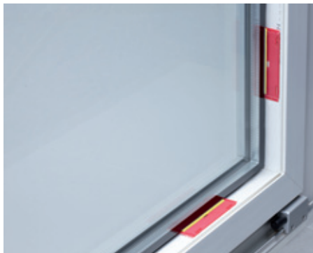
Угол с установленными подкладками
